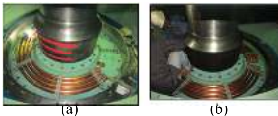
Gambar 3. (a) Proses pemasangan, (b) pengukuran dimensi guide bearing cooling tube
